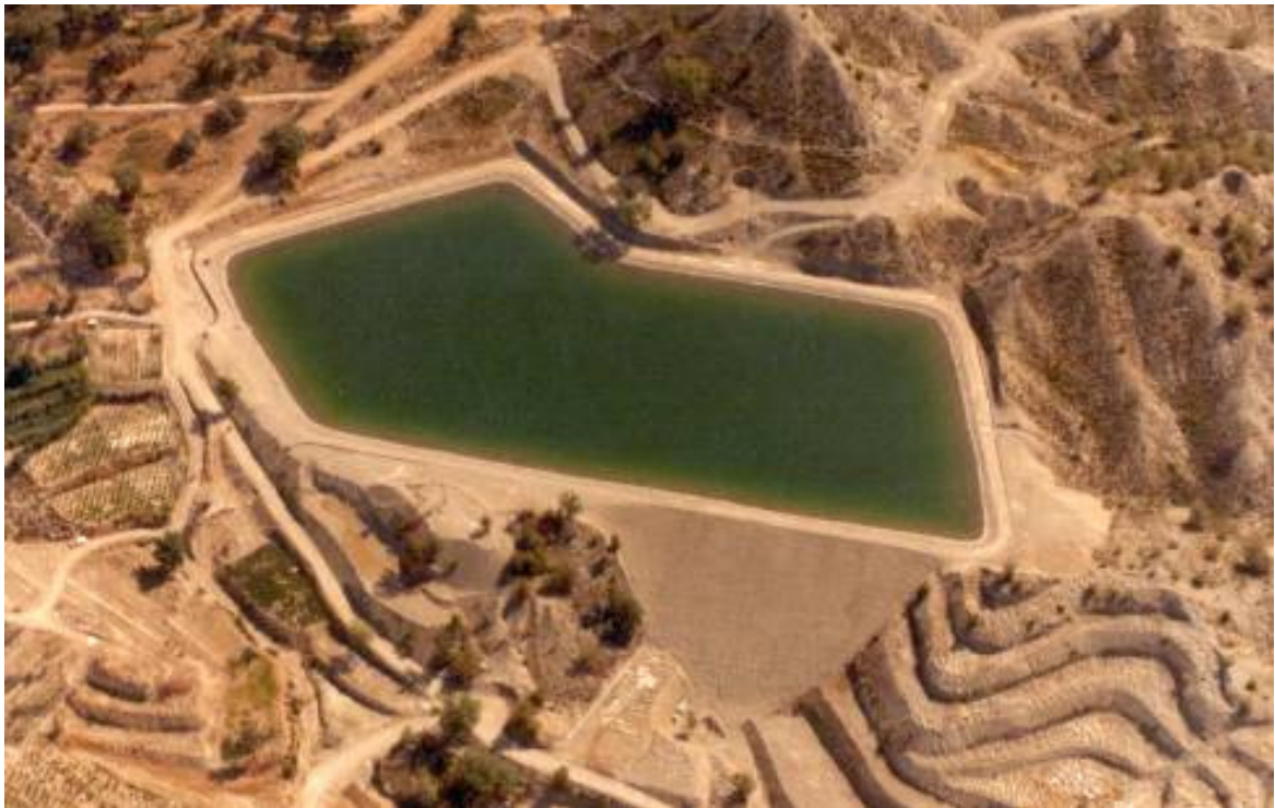
Φωτογραφία 1: Εξωποτάμια Λιμνοδεξαμενή
