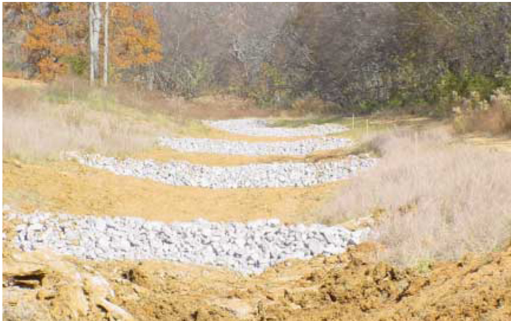
Σχήμα 5-1. Φωτογραφία σειράς ιζηματοπαγίδων
