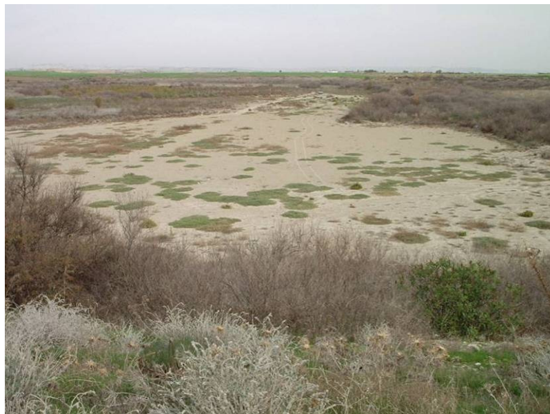
Σχήμα 3-4 Κοίτη φράγματος Κιτίου, Ιαν. 2006
