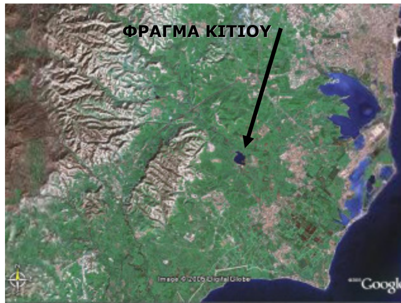
Σχήμα 3-1. Η θέση του φράγματος Κιτίου (Δορυφορική Φωτογραφία)
